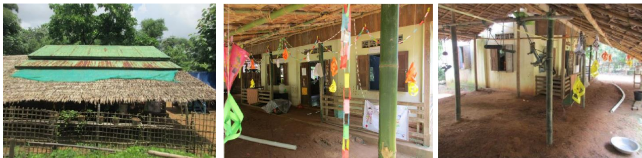
建て替え前は、建物の周りは竹と藁で作られ、雨風が吹き込むような状況
